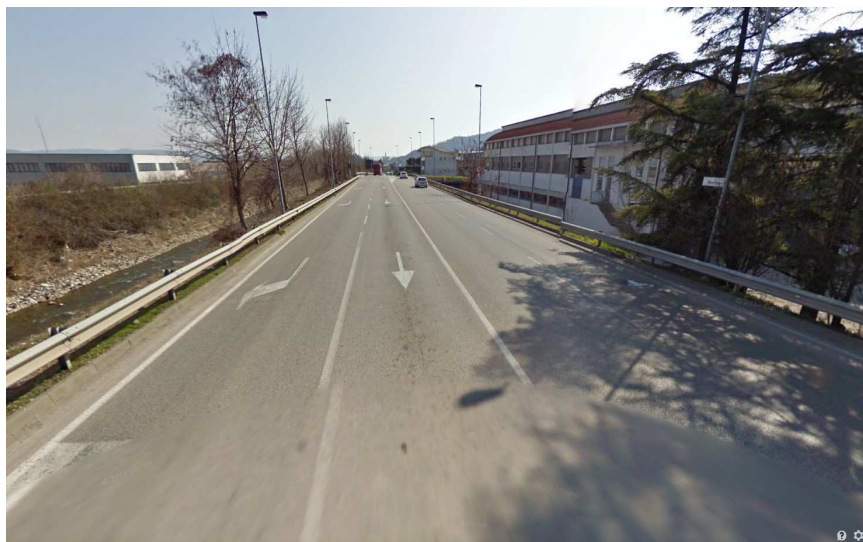
Telecamera 03: tipo fissa rilevazione targhe, Via Montorso direzione Montorso
